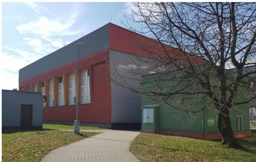
Obrázek č. 2 – Střecha tělocvičny po provedené rekonstrukci
