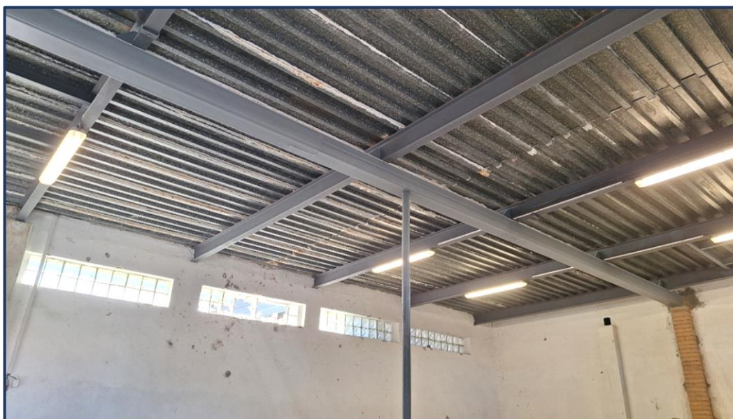
Obrázek č. 4 – Opravená stropní ocelová konstrukce v objektu učňovských dílen
